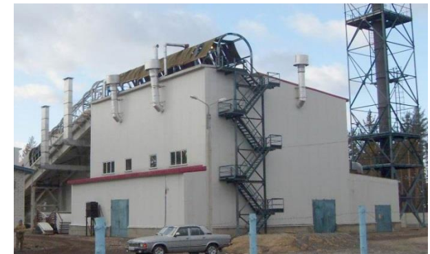
Котельная в пгт. Атамановка, Читинской области, мощностью 21 МВт на базе котлов КВ-Ф-7,56-115ПС
